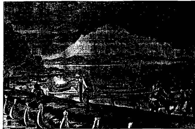
Fig. 10.11.- Este puente colgante sobre el río Desaguadero, al extremo sur del lago Titicaca, está montado sobre pontones de totora. Un punto importante en el camino incaico hacia el cuarto meridional del Imperio Incaico, este puente fue reconstruido en tiempos históricos hasta el siglo XIX (tomado de E. George Squier 1877: 309; 1974: 167).
