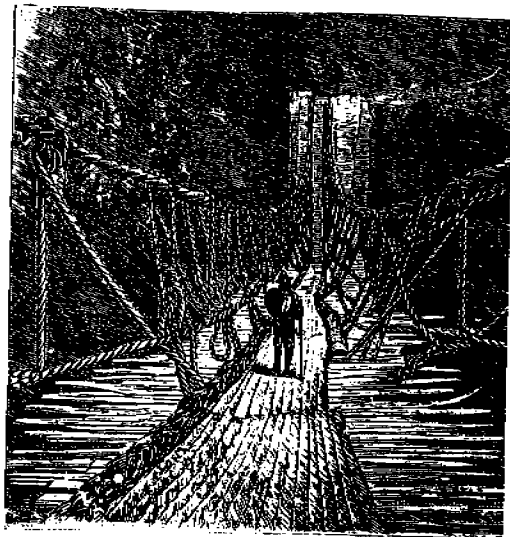
Fig. 10.15.— En este dibujo de Squier (1877: 559; 1974: 302), se nota la variedad de cables usados en la construcción del puente colgante, así como el ancho del piso.
