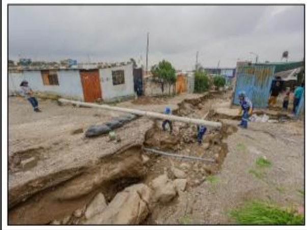
Sociedad Eléctrica Del Sur Oeste (SEAL) realizando trabajos para el restablecimiento del servicio eléctrico
