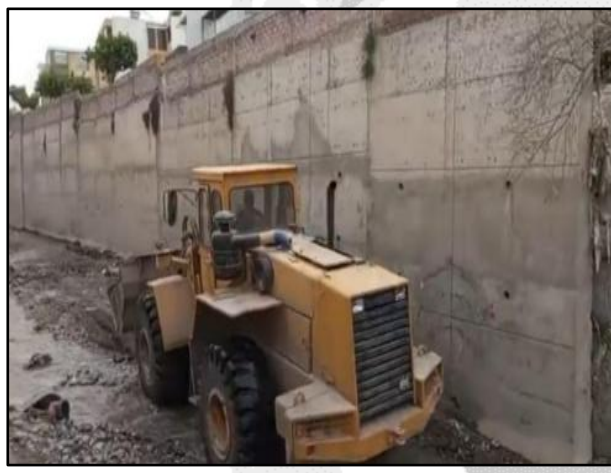
Limpieza y descolmatación de torrentera
