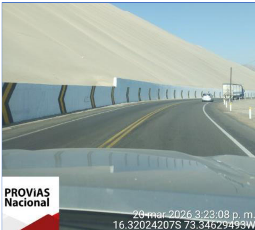
Toma fotográfica N° 07: Estado actual del muro de contención denominado "Cerro de Arenas" Km. 740+568 – km. 741+713, Tramo Atico – Ocoña, ruta PE-1S
