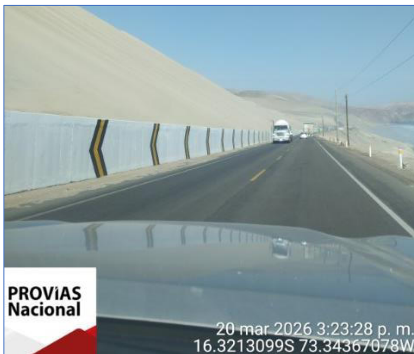
Toma fotográfica N° 10: Estado actual del muro de contención denominado "Cerro de Arenas" Km. 740+568 – km. 741+713, Tramo Atico – Ocoña, ruta PE-1S
