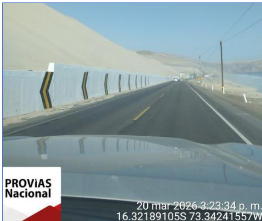
Toma fotográfica N° 11: Estado actual del muro de contención denominado "Cerro de Arenas" Km. 740+568 – km. 741+713, Tramo Atico – Ocoña, ruta PE-1S
