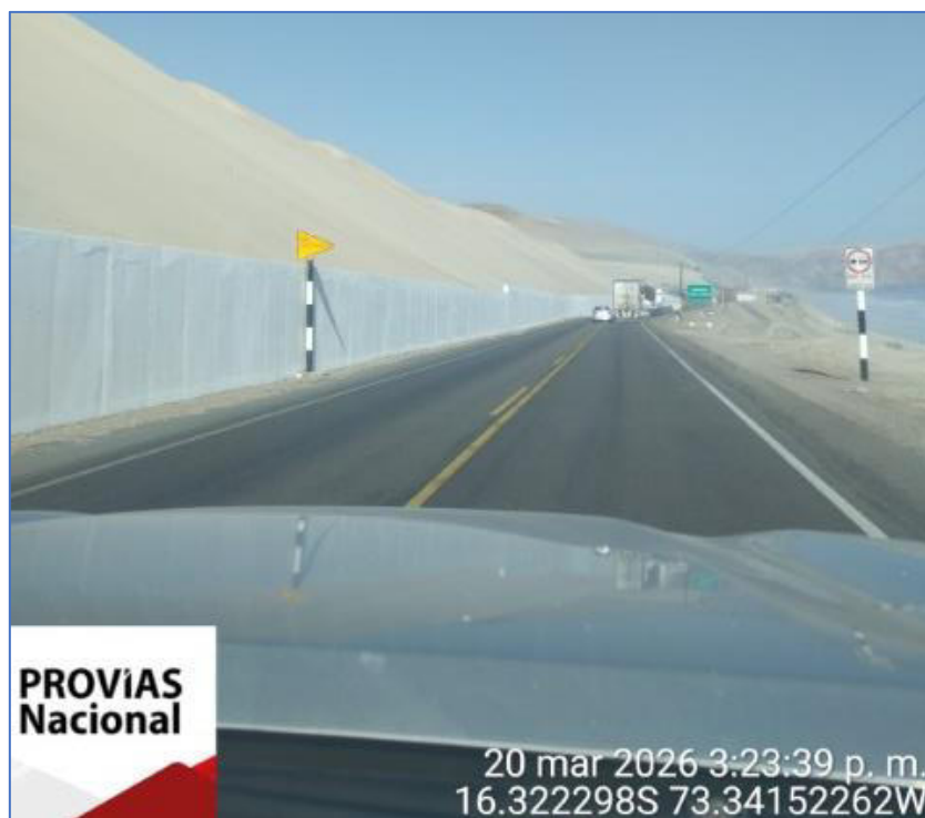
Toma fotográfica N° 12: Estado actual del muro de contención denominado "Cerro de Arenas" Km. 740+568 – km. 741+713, Tramo Atico – Ocoña, ruta PE-1S
