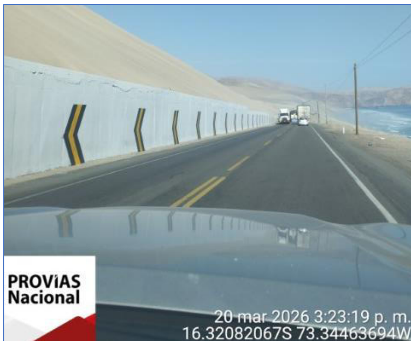
Toma fotográfica N° 09: Estado actual del muro de contención denominado "Cerro de Arenas" Km. 740+568 – km. 741+713, Tramo Atico – Ocoña, ruta PE-1S
