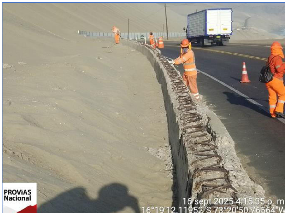
Toma fotográfica N° 01: Demolición de concreto dañado / Aplicación de aditivo transformador de óxido / Control de Tránsito Muro de contención denominado "Cerro de Arenas": Km. 740+568 – km. 741+713, Tramo Atico – Ocoña, ruta PE-1S
