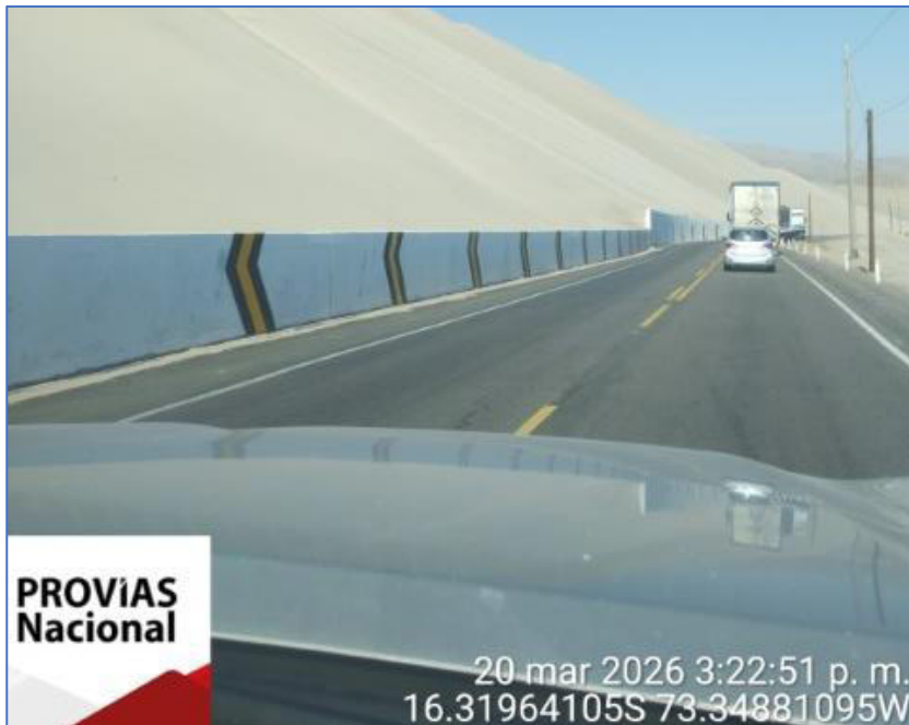
Toma fotográfica N° 01: Estado actual del muro de contención denominado "Cerro de Arenas" Km. 740+568 – km. 741+713, Tramo Atico – Ocoña, ruta PE-1S
