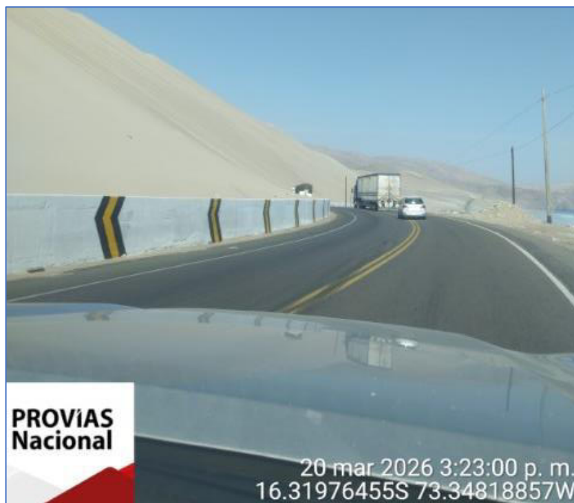
Toma fotográfica N° 04: Estado actual del muro de contención denominado "Cerro de Arenas" Km. 740+568 – km. 741+713, Tramo Atico – Ocoña, ruta PE-1S
