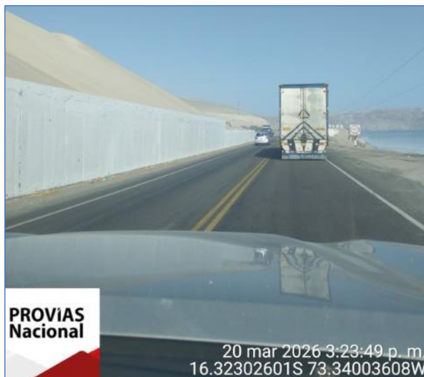
Toma fotográfica N° 14: Estado actual del muro de contención denominado "Cerro de Arenas" Km. 740+568 – km. 741+713, Tramo Atico – Ocoña, ruta PE-1S
