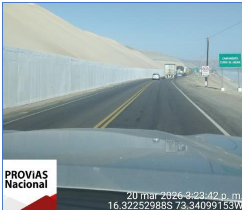
Toma fotográfica N° 13: Estado actual del muro de contención denominado "Cerro de Arenas" Km. 740+568 – km. 741+713, Tramo Atico – Ocoña, ruta PE-1S
