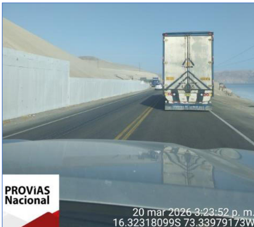
Toma fotográfica N° 15: Estado actual del muro de contención denominado "Cerro de Arenas" Km. 740+568 – km. 741+713, Tramo Atico – Ocoña, ruta PE-1S
