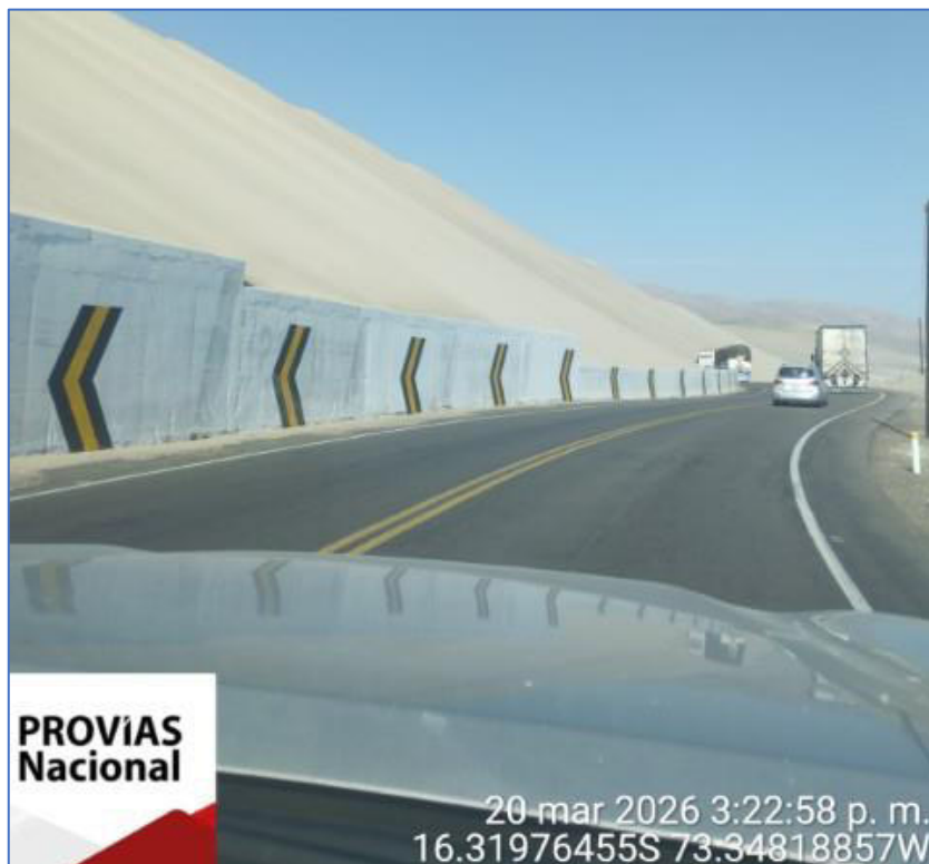
Toma fotográfica N° 03: Estado actual del muro de contención denominado "Cerro de Arenas" Km. 740+568 – km. 741+713, Tramo Atico – Ocoña, ruta PE-1S
