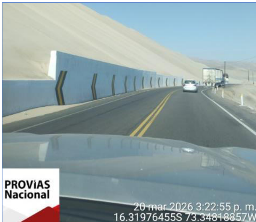
Toma fotográfica N° 02: Estado actual del muro de contención denominado "Cerro de Arenas" Km. 740+568 – km. 741+713, Tramo Atico – Ocoña, ruta PE-1S
