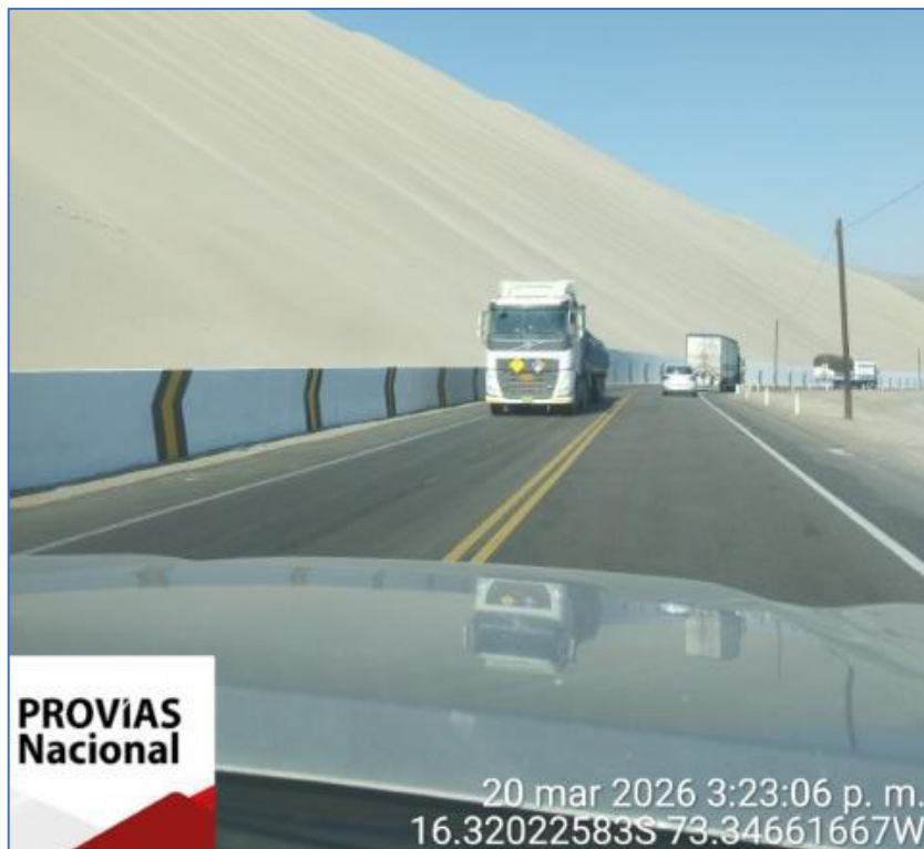
Toma fotográfica N° 06: Estado actual del muro de contención denominado "Cerro de Arenas" Km. 740+568 – km. 741+713, Tramo Atico – Ocoña, ruta PE-1S
