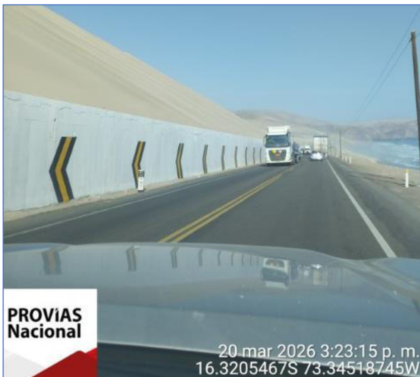
Toma fotográfica N° 08: Estado actual del muro de contención denominado "Cerro de Arenas" Km. 740+568 – km. 741+713, Tramo Atico – Ocoña, ruta PE-1S
