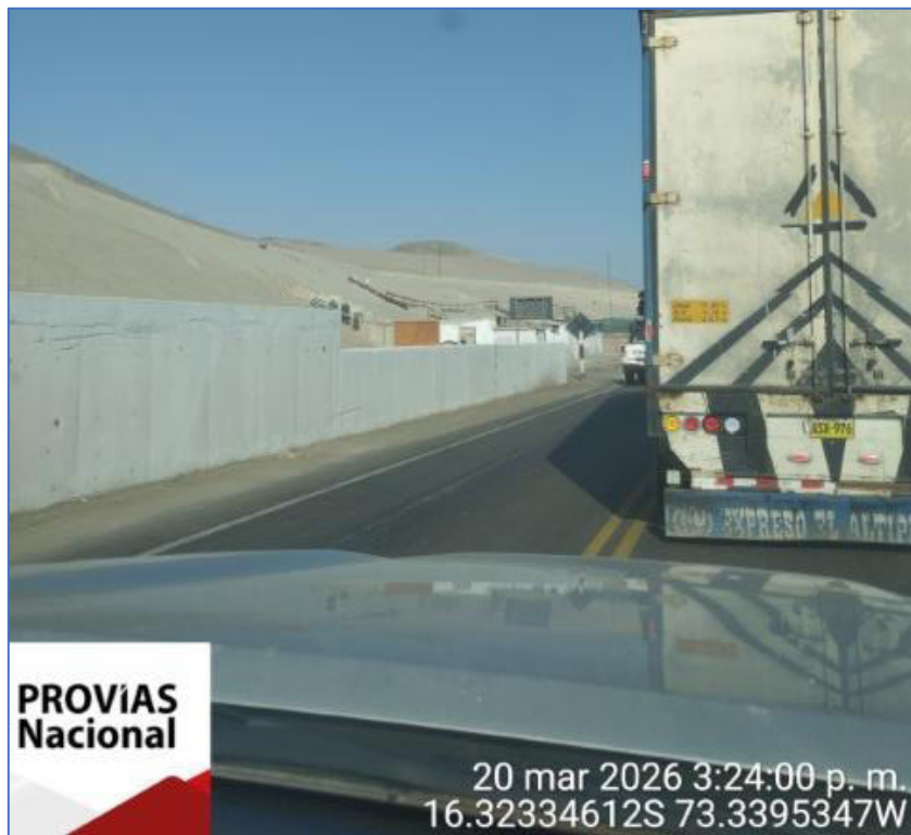
Toma fotográfica N° 16: Estado actual del muro de contención denominado "Cerro de Arenas" Km. 740+568 – km. 741+713, Tramo Atico – Ocoña, ruta PE-1S
