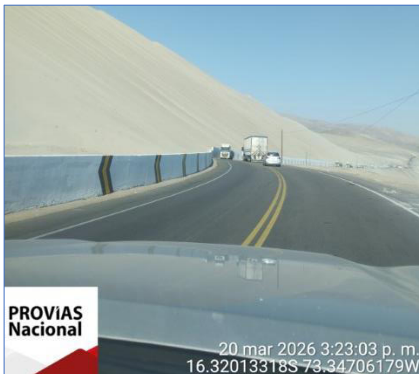
Toma fotográfica N° 05: Estado actual del muro de contención denominado "Cerro de Arenas" Km. 740+568 – km. 741+713, Tramo Atico – Ocoña, ruta PE-1S
