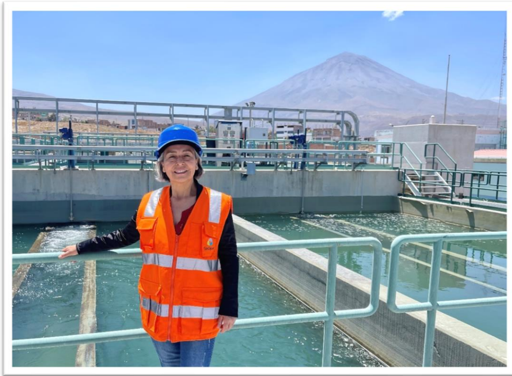
Imagen 17: Visita a la Planta de Tratamiento de Agua Potable "Miguel de la Cuba Ibarra".
