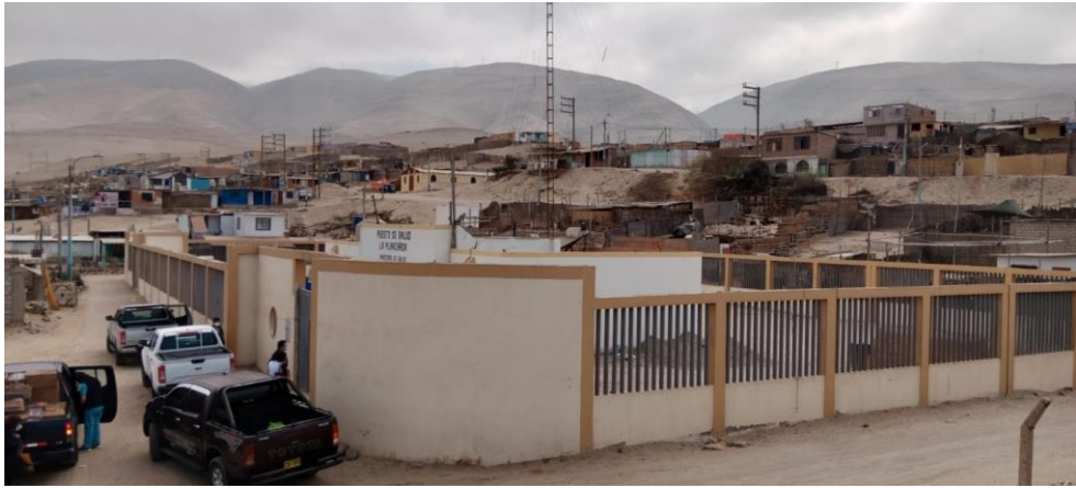
Puesto de Salud del Centro Poblado La Planchada
