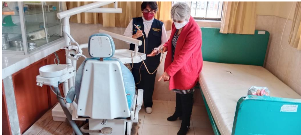
Las máquinas de odontología en estado de abandono y óxido
