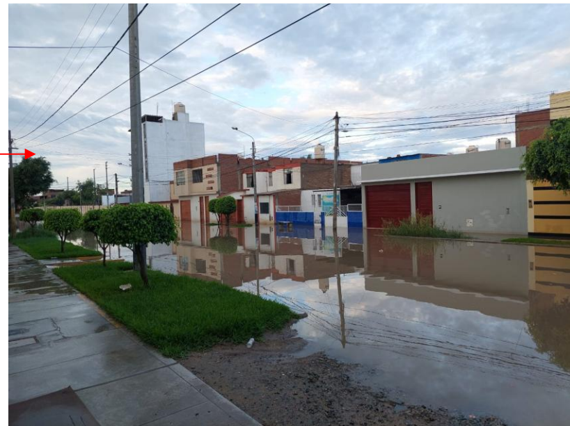
Urb. Caja de depósitos 3/2023
