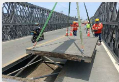
Limpeza de vigas puente modular
