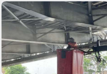
Limpeza de vigas puente modular
