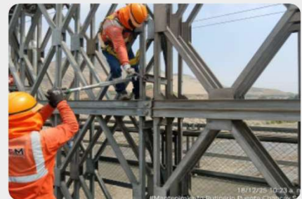
Ajuste de pernos puente modular
