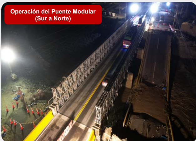
Instalación de Puentes Modulares
