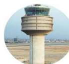
NUEVA TORRE DE CONTROL
