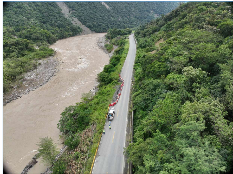
Imágenes aéreas del sector afectado, ubicado entre el km 256+840 al km 256+900
