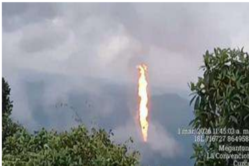
Fuga de LGN y deflagración en estación de válvulas TGP (KP 43, Cusco)
