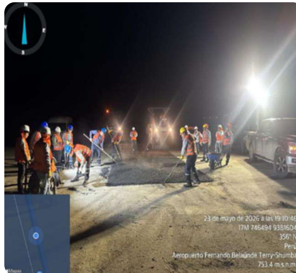
Colocación de mezcla asfáltica en caliente y rastrillado
