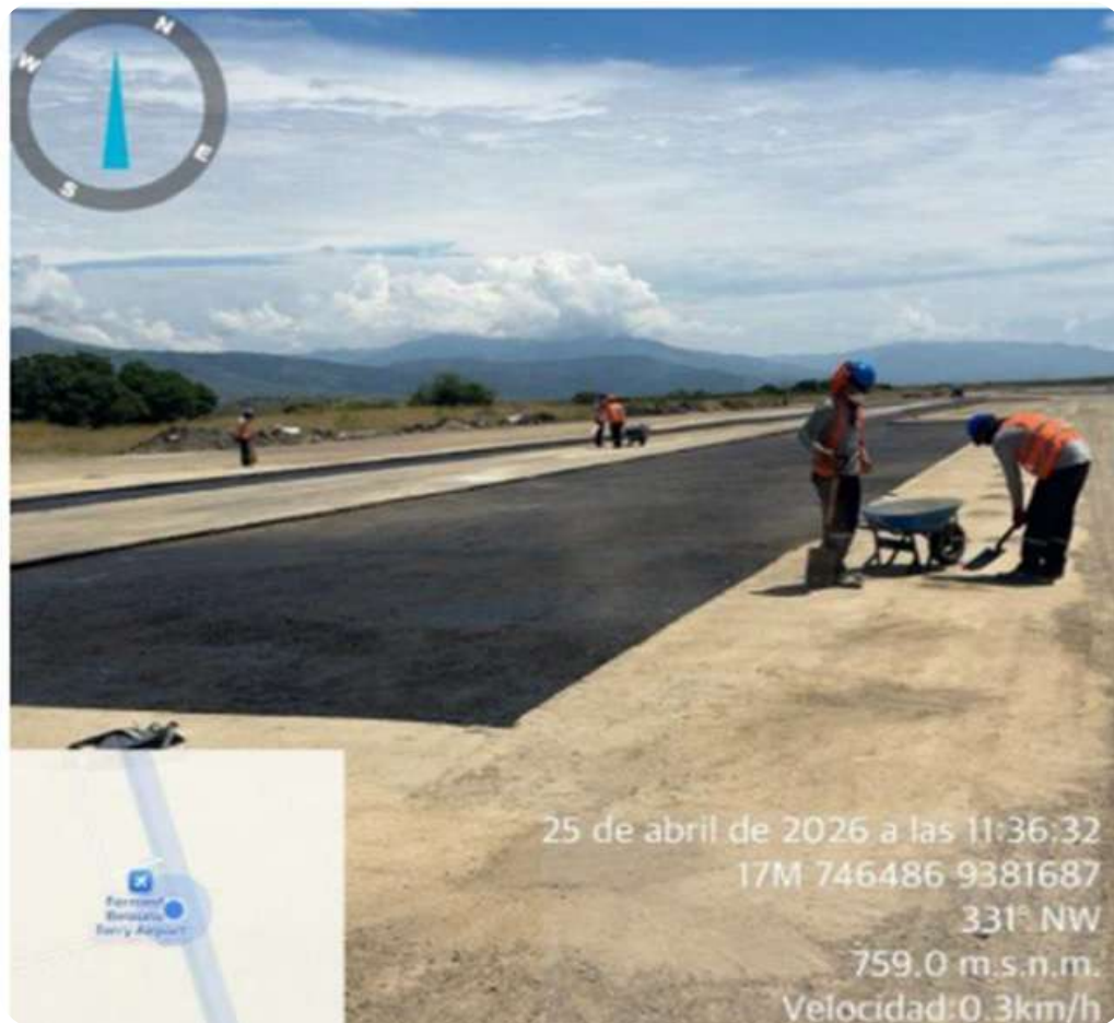
Imprimación de la sección previamente excavada.
