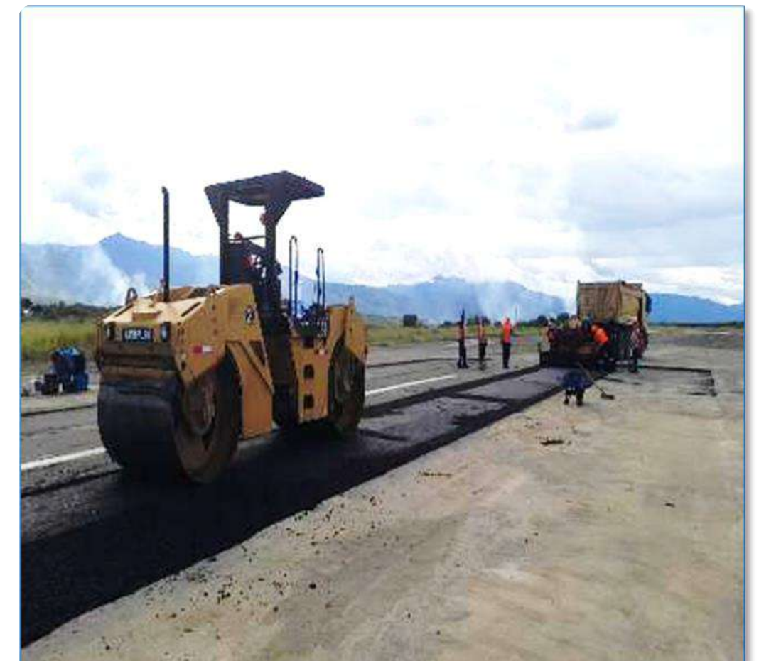
Compactación y limpieza
