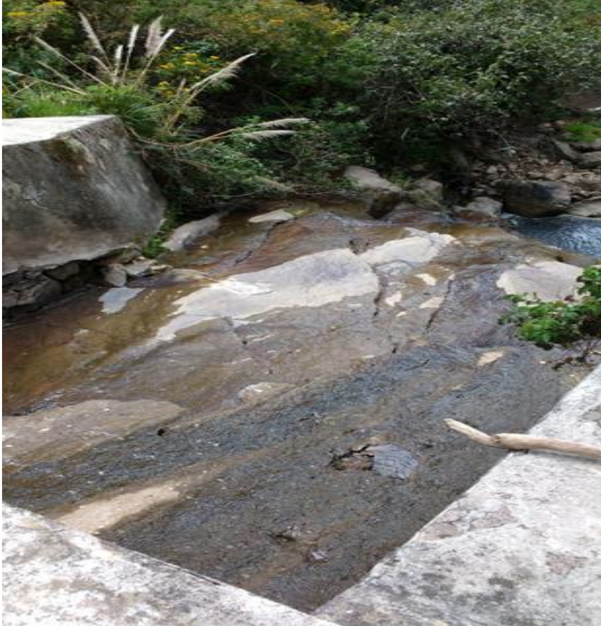
Quebrada Totoras: (07) Cauce con afloramientos de rocas volcánicas silicificadas, mayormente al estado sana, dura y resistente. (08) Captación en la quebrada Totoras, zona del canal en rocas volcánicas silicificadas y moderada meteorización; se observan bloques en las laderas.
