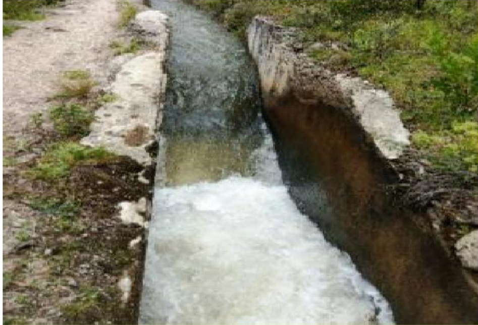
CANAL HUALLABAMBA, KM 8+500, CON AGUA
